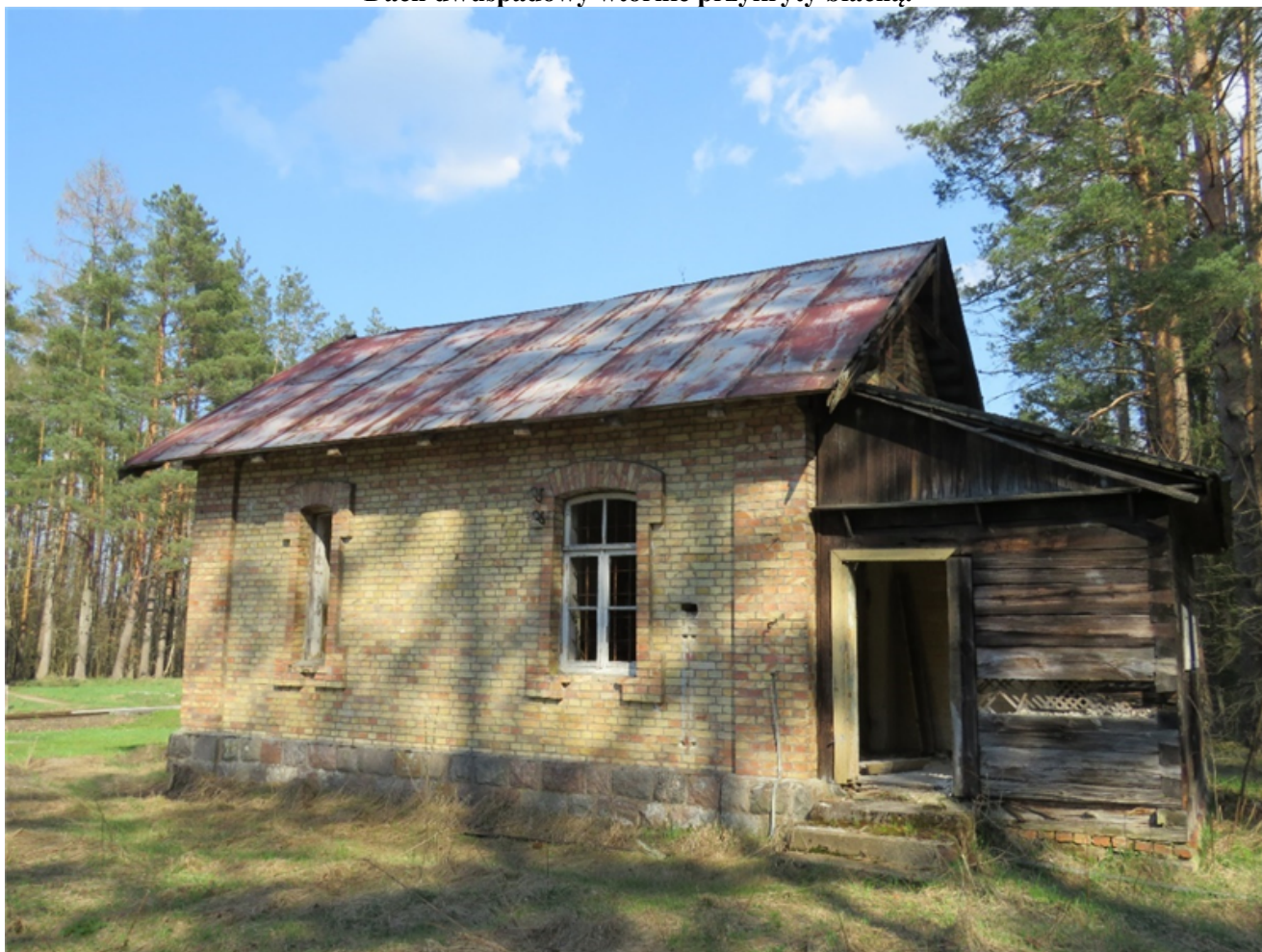
Dach dwuspadowy wtórnie przykryty blachą.
