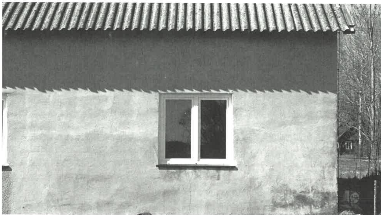
Rys.6 Widok rys i spękań widocznych na elewacji
