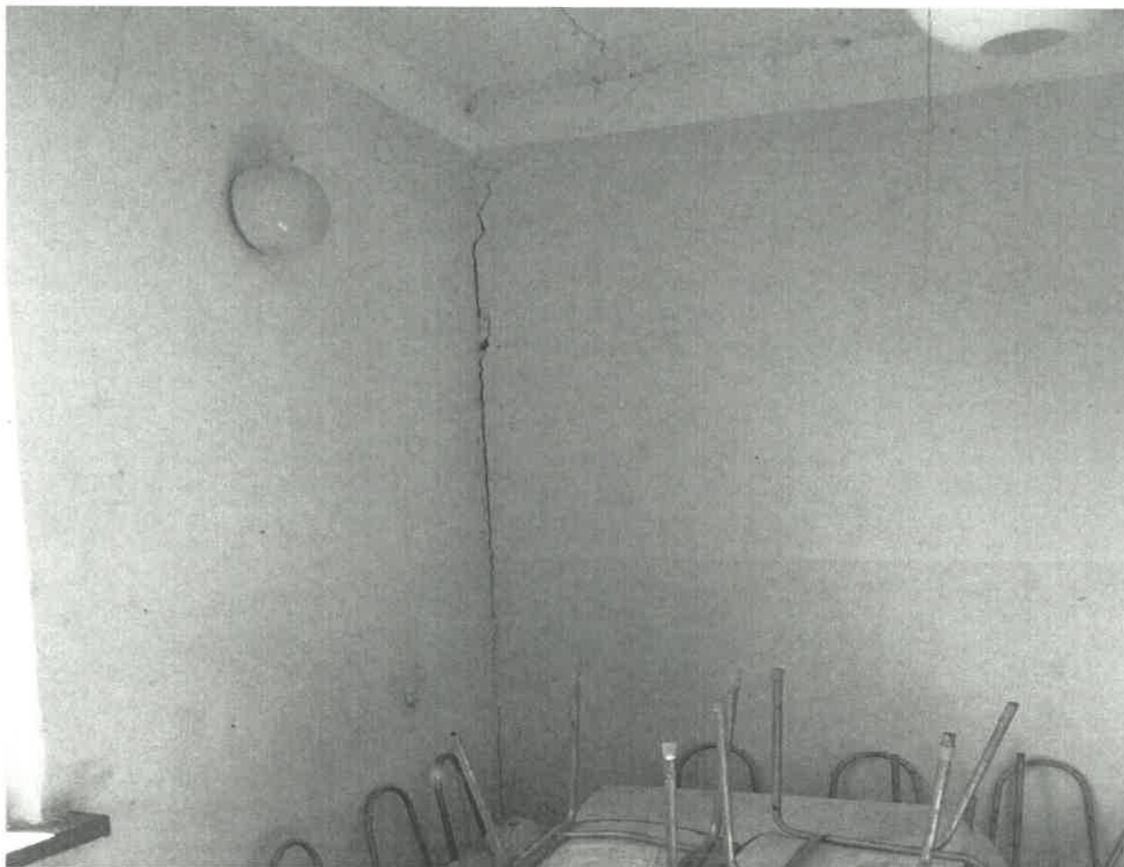
Rys. 4. Widok rys i spękań od wewnątrz budynku
