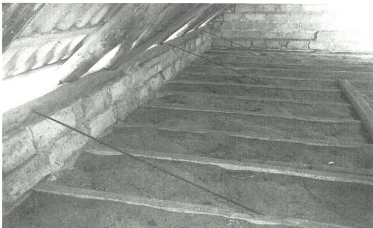
Rys. 5. Brak wieńców ściennych spinających budynek
