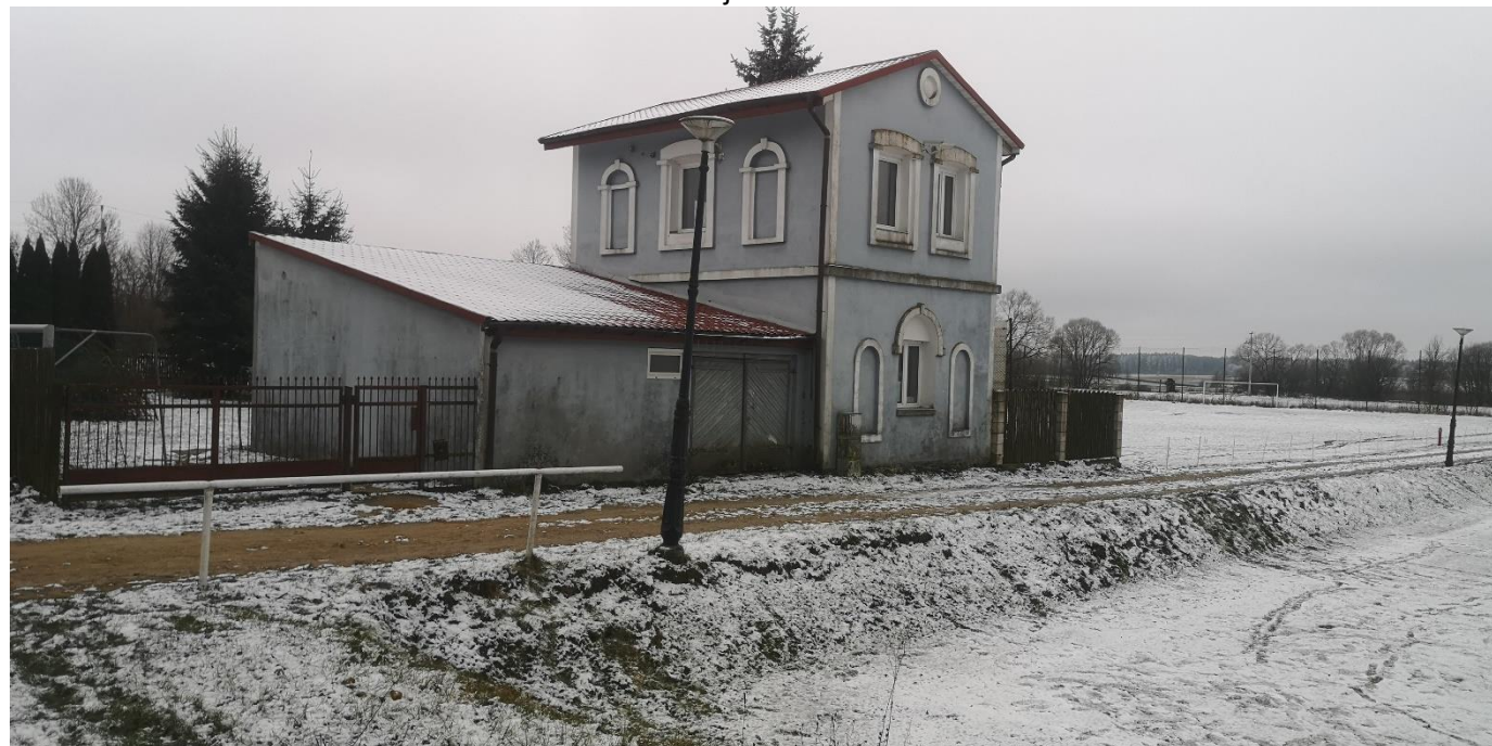
Widok na stadion i budynek
